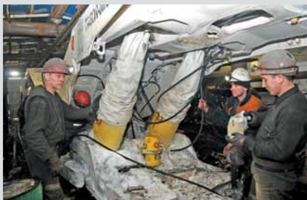
Монтаж гидравлики управления механизированной крепи ТАГОР-0823 на шахте «Бутовская»
