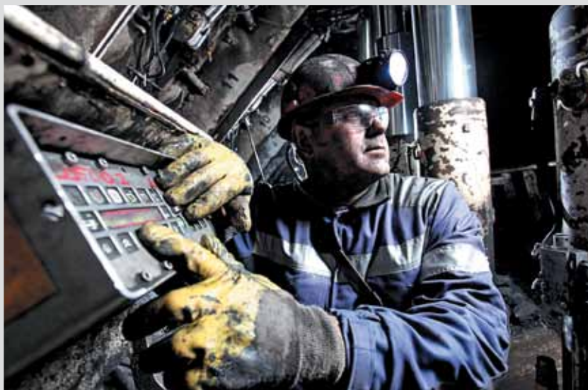
ОАО «СУЭК-Кузбасс» шагает в ногу со временем: управление секциями крепи DBT на шахте «Талдинская» (сверху); диспетчерская шахты имени С.М. Кирова ОАО «СУЭК-Кузбасс», для комплексной автоматизации и обеспечения безопасности горных работ используется система компании Davis Derby (слева); орошение комбайна SL-500 на шахте имени 7 Ноября ОАО (справа)
